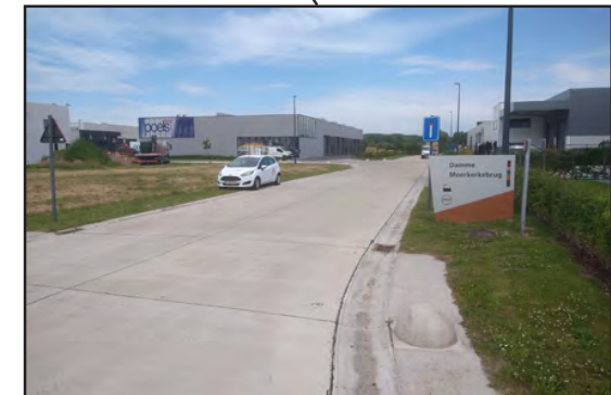
Bestaande toestand: bedrijventerrein Moerkerkebrug
