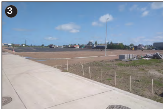
Aanleg evenementenplein met randparking
