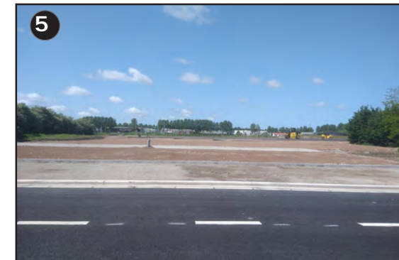
Zicht op westen vanaf Natiënlaan (rechts: Winsol)
